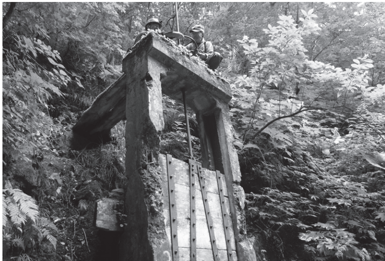
隧道の入口には手で開け閉めする樋門が設けられている。 田植え前に開けて、水を流し清掃する。右側が高橋一幸さん。
