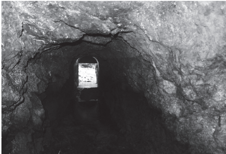
手掘りで掘り進めた隧道。沢側から山側の開口部を見通す。 固い岩盤であるのが見てとれる。ノミの跡がくっきりと残っていた。
