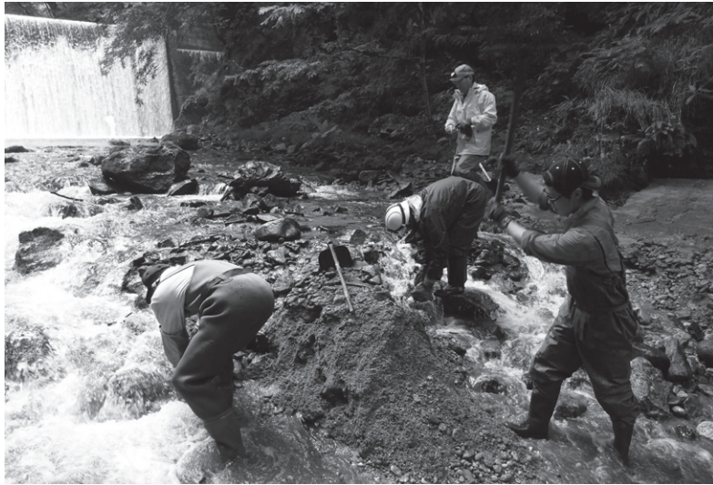
大森平の水田の生命線、仙北沢。毎年田植えの前の時期、集落の人は溪谷に下りて、雪で崩れ落ちた沢筋の岩や石、泥の撤去作業を行う
